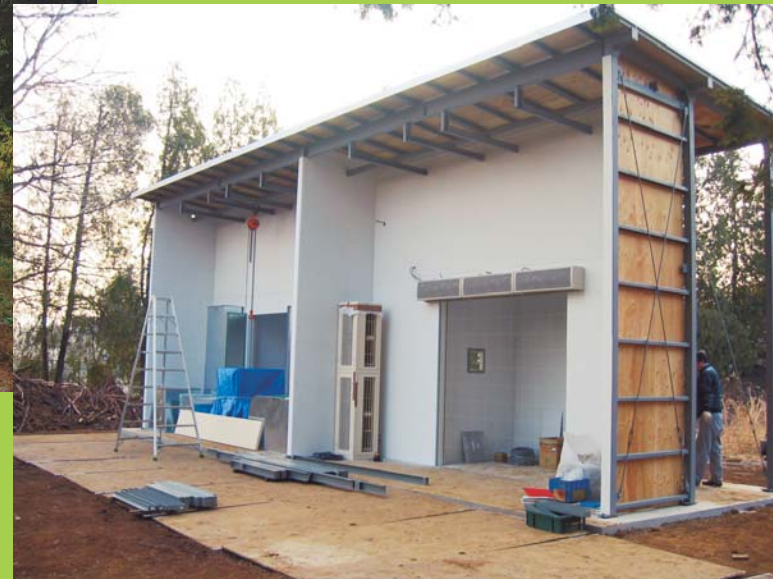
▼防虫性能試験専用施設
